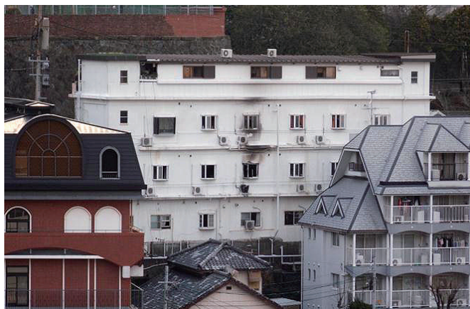
火災建物（中央白の建物）の外観
